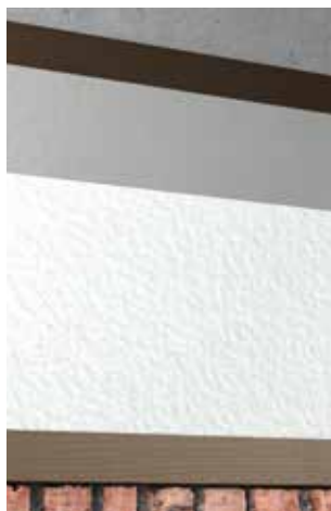
2 Nałożenie zaprawy Fachwerkmörtel
