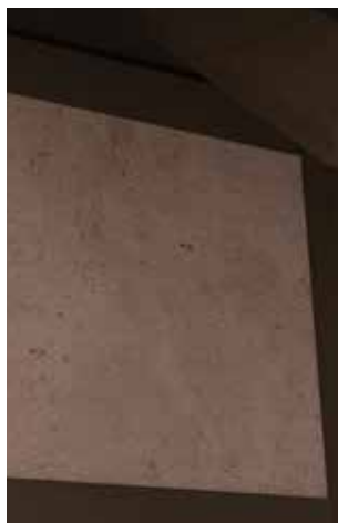
2 Naprawa za pomocą tynku glinianego
