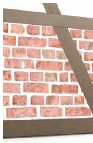
3 Spoinowanie na nowo z użyciem zaprawy FM ZF
