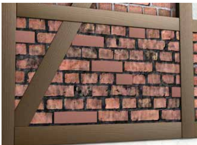
1 Wymiana lub uzupełnienie uszkodzonych cegieł z użyciem RM pro
