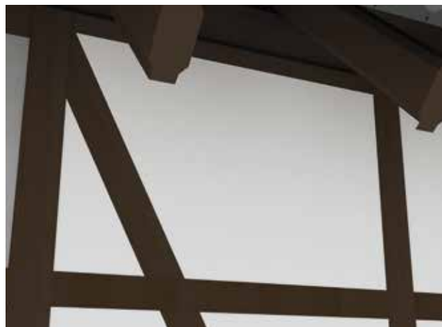
3 Gruntowanie środkiem Primer Hydro SF, Silikatfestiger i malowanie farbą Color CL Historic (dawn. Historic Kalkfarbe)
