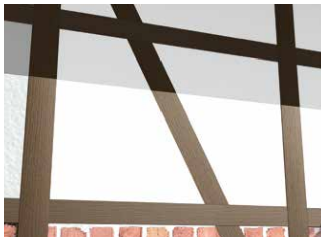
3 Zagruntowanie środkiem Primer Hydro SF, Silikatfestiger i malowanie farbą wapienną Color CL Historic (dawn. Historic Kalkfarbe)
